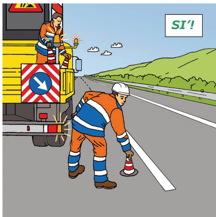
Figura 59 – Posizionamento dei coni o defleco: comportamento corretto
